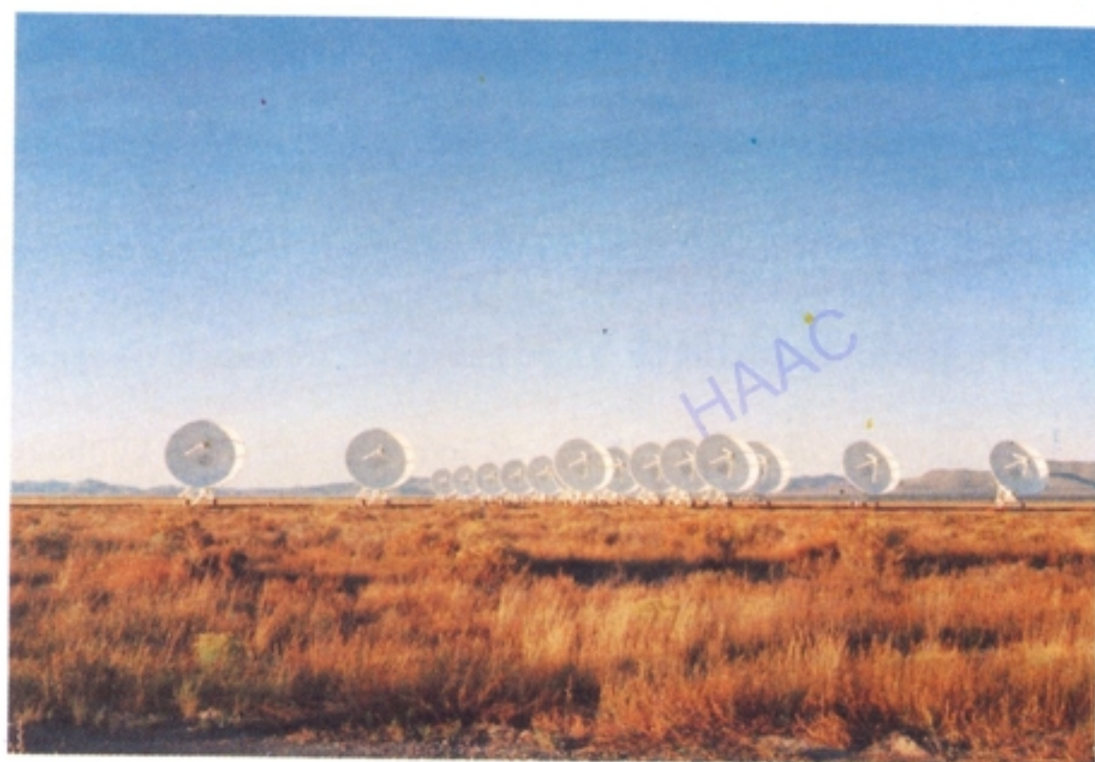
Hình 33 : Dây ăngten của Đài thiên văn vô tuyến quốc gia Mỹ tại New Mexico. Hệ thống viễn kính vô tuyến này gồm 27 ăngten đường kính 25 mét đặt theo hình chữ Y rải rác trên một khu rộng 35 km. Dây ăngten hoạt động theo phương thức giao thoa có khả năng phân giải lớn. Hệ thống viễn kính vô tuyến này có độ phân giải tối đa, có thể phân biệt được những chi tiết nhỏ bằng hạt gạo ở xa 4 km.
